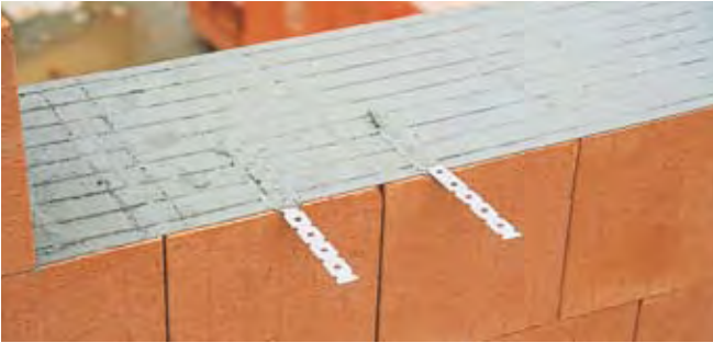
Stumpfstoß: Einsetzen der in Dünnbettmörtel eingetauchten Flachstahllanker
