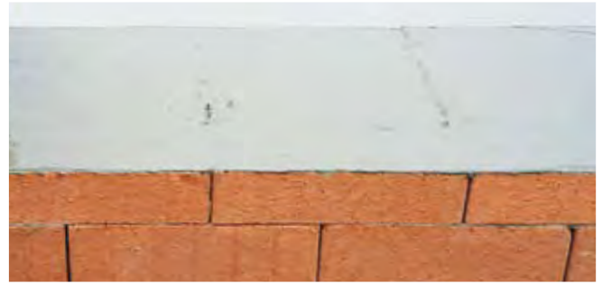
Der Höhenausgleich an der Fensterbrüstung wird mit V.Plus®-Deckelung vor Regen und Schnee geschützt.
