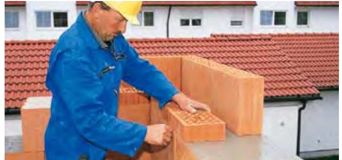
Vorbereitung für Deckenaufleger; die Wärmedämmung wird bis zum aufgehenden Mauerwerk durchgezogen.
