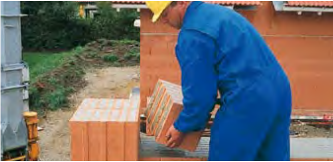
Versetzen des Eckanschlussziegels mit Mörtelauftrag auf der Verzahnung
