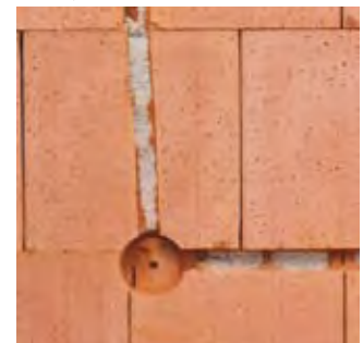
Schlitzen und Kronenbohrung für Elektrodoesen
