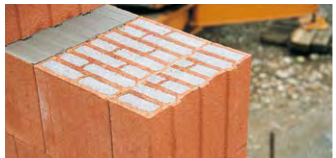
Der Ausgleichsziegel ist wärmebrückenfrei versetzt.
