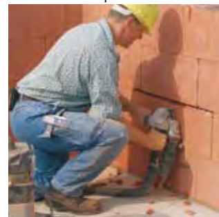
Schlitzen und Kronenbohrung für Elektrodoesen
