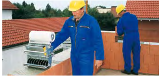
Die schnelle Wand: Walzen im Schrittempo und Versetzen gleichzeitig
