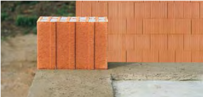
Setzen des ersten Ziegels lot- und fluchtgerecht
