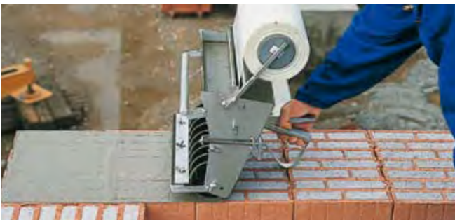
Ansetzen mit der V.Plus®-Walze im Eckbereich
