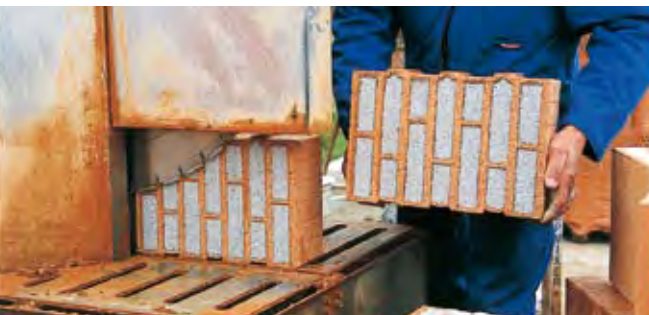
Höhenausgleich: Ausgleichsziegel mit der Nasssäge schneiden
