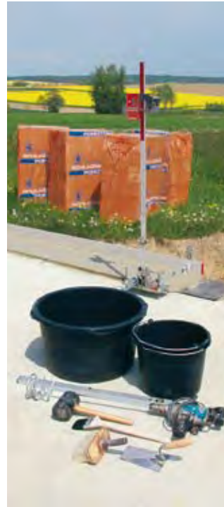
Grundausrüstung der Planziegel-Baustelle
