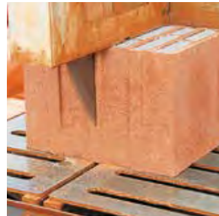
Vertikale Ausgleichsziegel mit der Nasssäge oder der Elu-Säge schneiden
