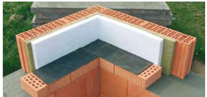
Fertiges Deckenaufleger mit Faserdämmstoff und Wärmedämmplatte (wasserabweisend)
