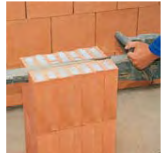
Vertikale Ausgleichsziegel mit der Nasssäge oder der Elu-Säge schneiden
