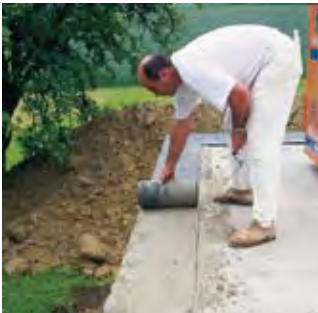
Auf die Bodenplatte wird eine Bitumenpappe auf Mörtel verlegt.
