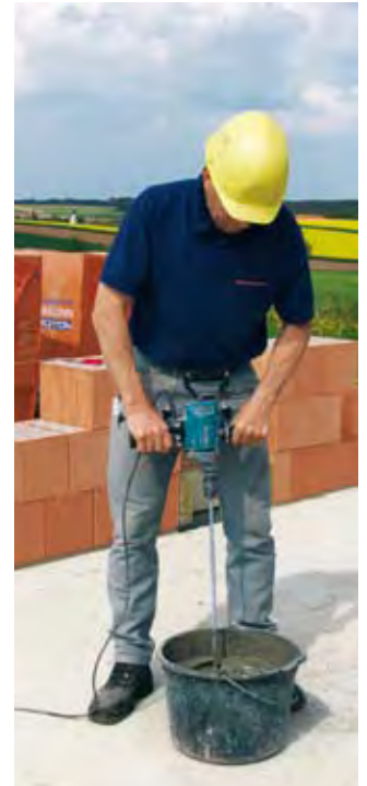
Anrühren des Dünnbettmörtels mit dem Mörtelquirl
