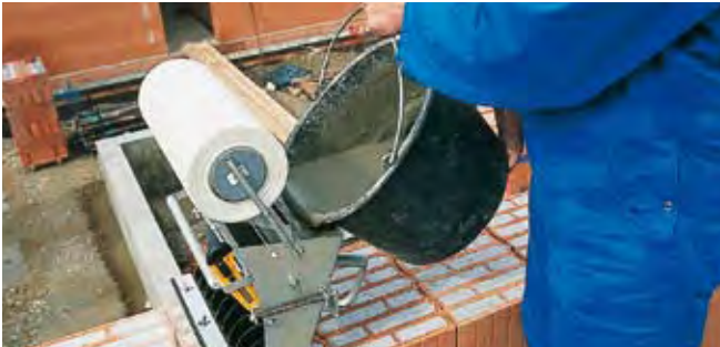
Befüllen der V.Plus®-Walze mit V.Plus®-Mörtel
