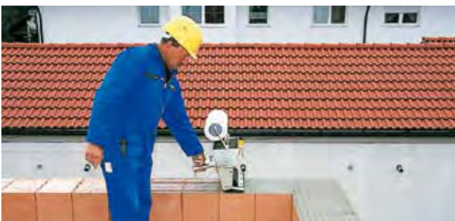
Einfacher und schneller Mörtelauftrag mit der V.Plus®-Walze
