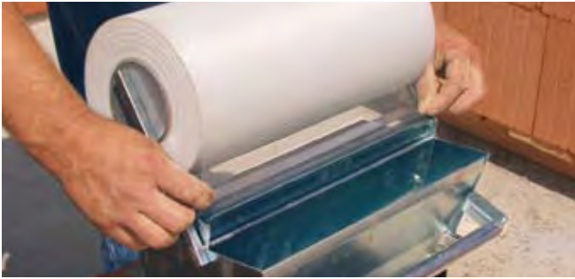
Einlegen des Gewebes in die V.Plus®-Walze
