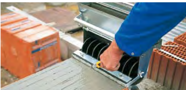
Abschneiden des V.Plus®-Glasfilamentgewebes mit Hilfe der Abschnittleiste und einem Teppichmesser
