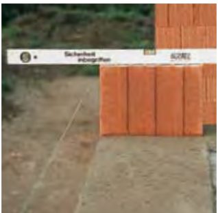
Der erste Ziegel mit gespannter Richtschnur
