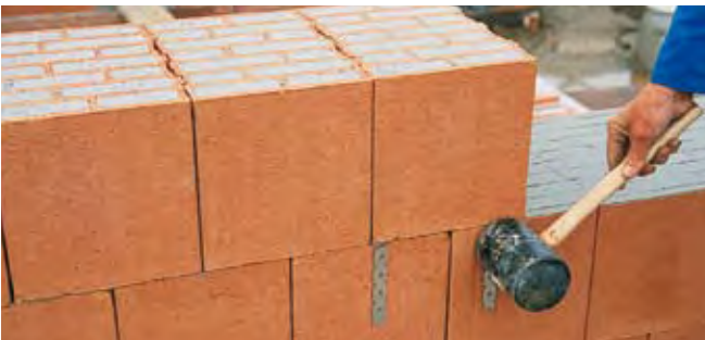
Umbiegen der Flachstahllanker mit dem Gummihammer
