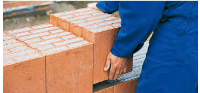
Einfaches knirsches Versetzen des Planziegels ohne Gummihammer absolut plan
