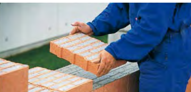
Versetzen des Ausgleichsziegels z.B. im Bereich einer Fensterbrüstung vermeidet Wärmebrücken
