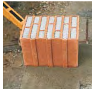
Der erste Ziegel mit gespannter Richtschnur
