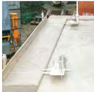
Anlegen des Mörtelbettes mit dem Justierboy.
