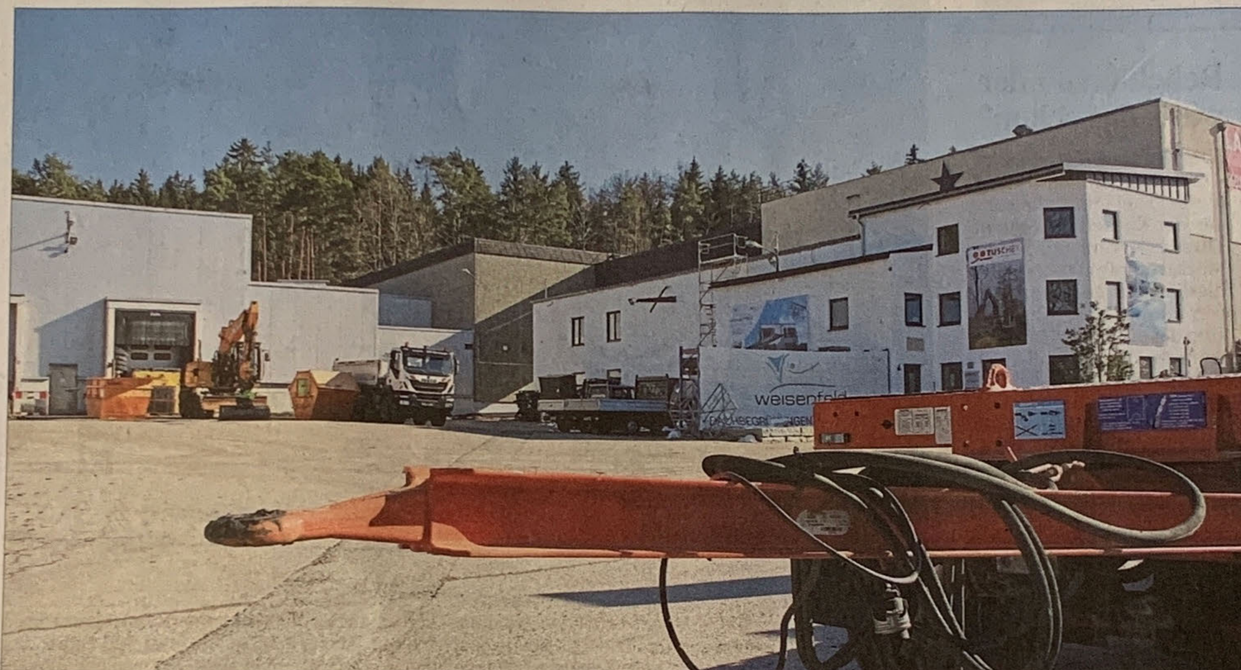
Die ersten Firmen sind eingezogen: Im ehemaligen Milchwerk sind Büro- und Lagerflächen geplant. Das Areal soll noch erweitert werden. Foto: Lodermeyer
