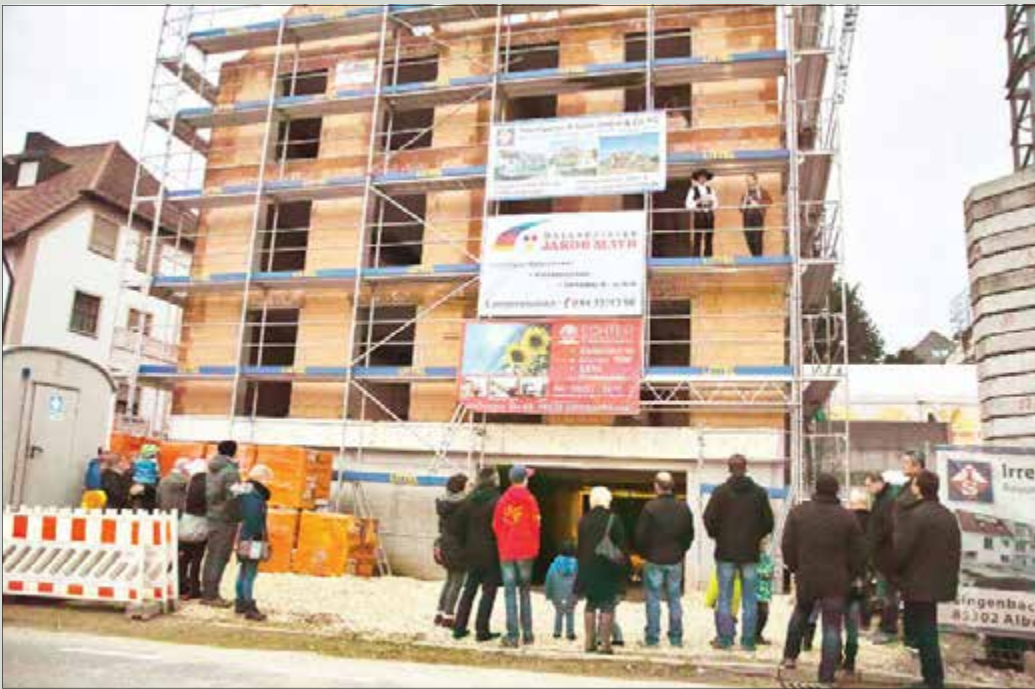
Beim Richtfest der neuen Wohnanlage PfaffelGarten war auch Daniel Seitz von der Firma Irrenhauser und Seitz anwesend. Die massive Ziegelbauweise garantiert ein gesundes Wohnklima. Foto: Eibisch
